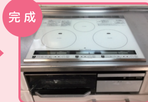
ガスコンロを外した枠に IHクッキングヒーターをはめこみ、完成!
